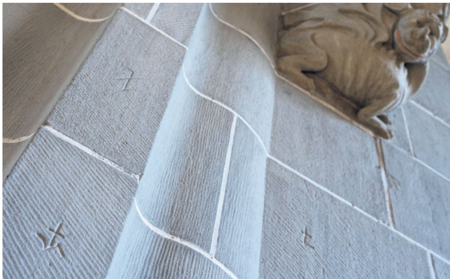
An diesem Pfeiler des südlichen Seitenschiffs in der St.-Oswald-Kirche sind auf kleiner Fläche gleich drei Steinmetzzeichen auszumachen.
